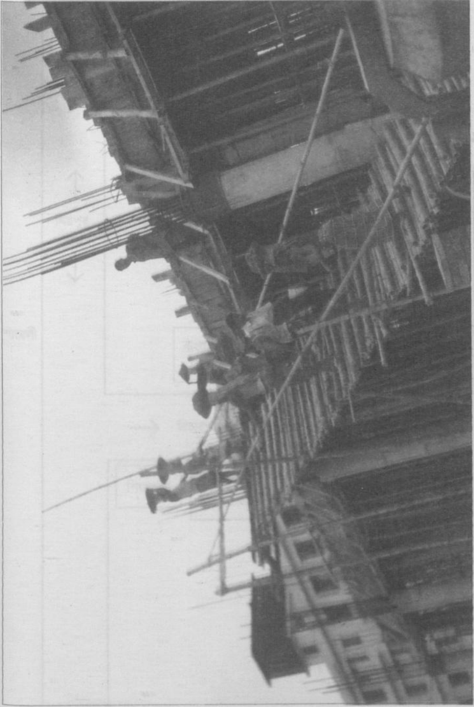
জাতীয় আরকাইভস-এর নিজস্ব ভবন নির্মাণ কাজ। Construction of Bangladesh National Archives Ehaban in Progress.
